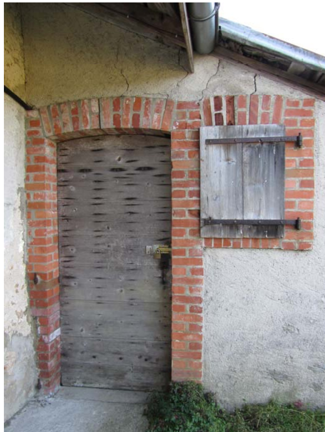
Au nord la chambre à lait. L'arrière révèle des éléments architecturaux intéressants et inédits. Comme cette porte de l'annexe en carrons de terre cuite.
